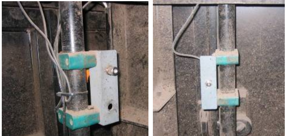
KUVA 7. Valokenno, vasemmalla vastaanotin, oikealla valolähde.
