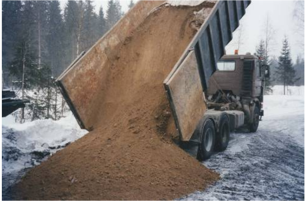
Kuva 5. Oy Metsä-Botnia Ab:n Äänekosken tehtaassa itsekoveutusmenetelmällä käsiteltyä tuhkaa tuodaan varastolle metsälevitystä varten.
