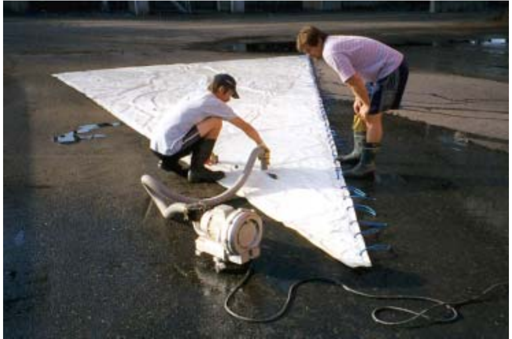
Eristepeite puhdistetaan ja ilma poistetaan.
