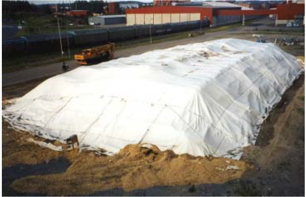
Eristeitteellä katettu kasa ennen purkamisen alkamista.
