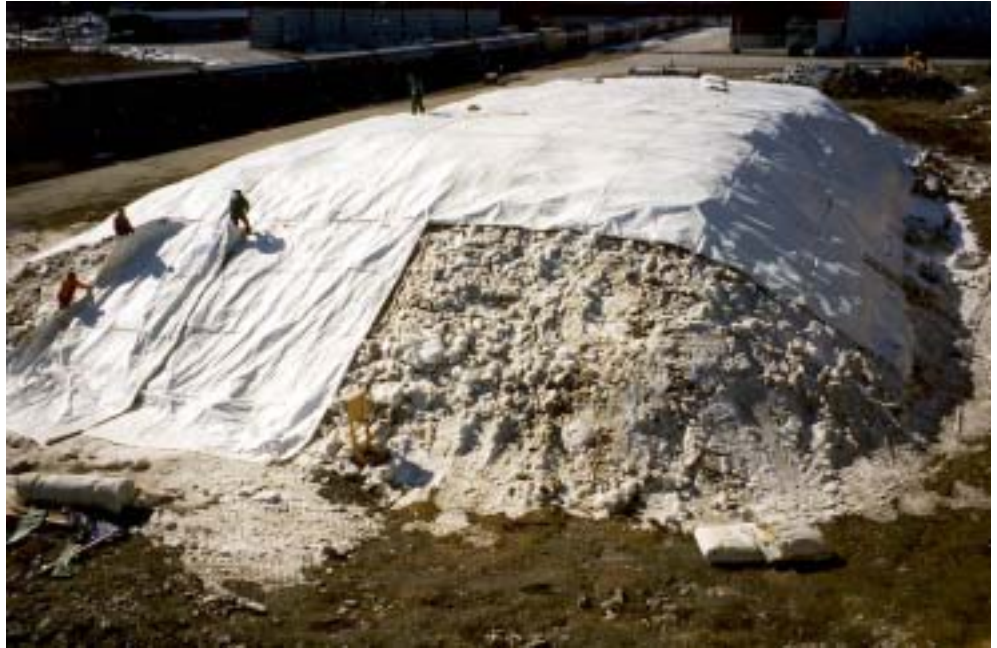
Eristebeitettä levitetään lumella peitetyn puukasan päälle.
