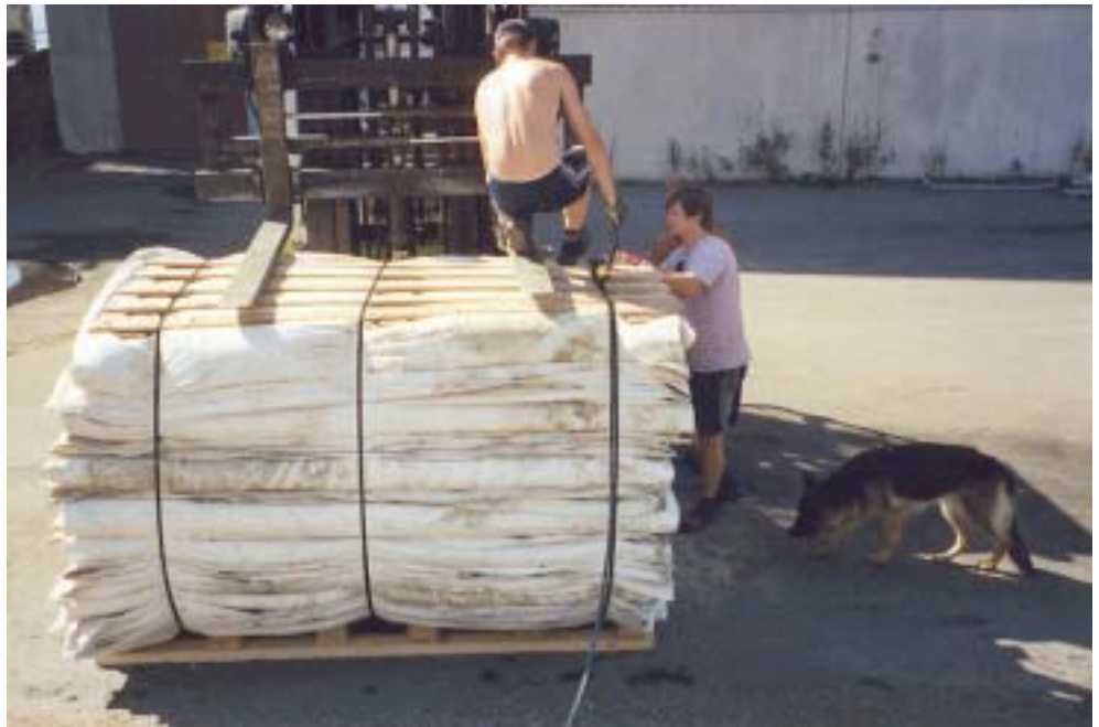
Puhdistetut eristeitteet pinkataan kuljetuskuntoon.
